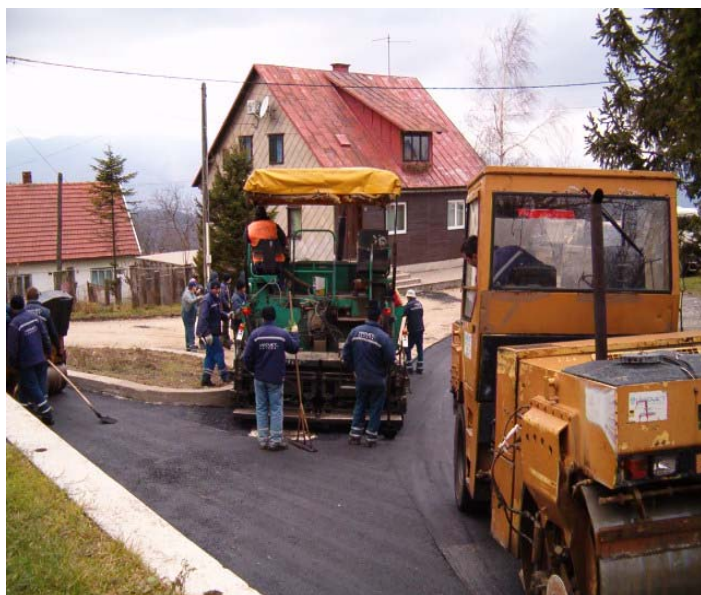
Asfaltiranje dijela Selske ulice
