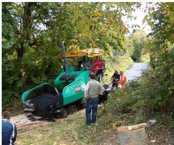
Asfaltiranje naselja Rogi
