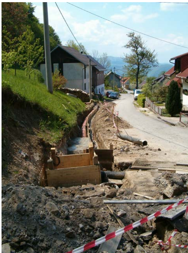
Radovi na sustavu odvodnje u Velikom Selcu
