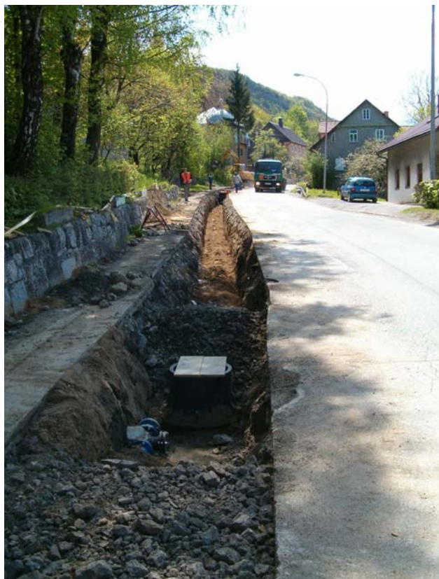
Radovi na sustavu odvodnje u Goranskoj ulici
