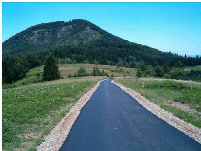
Radovi na sanaciji ceste Divjake-Hribac-Hlevci
