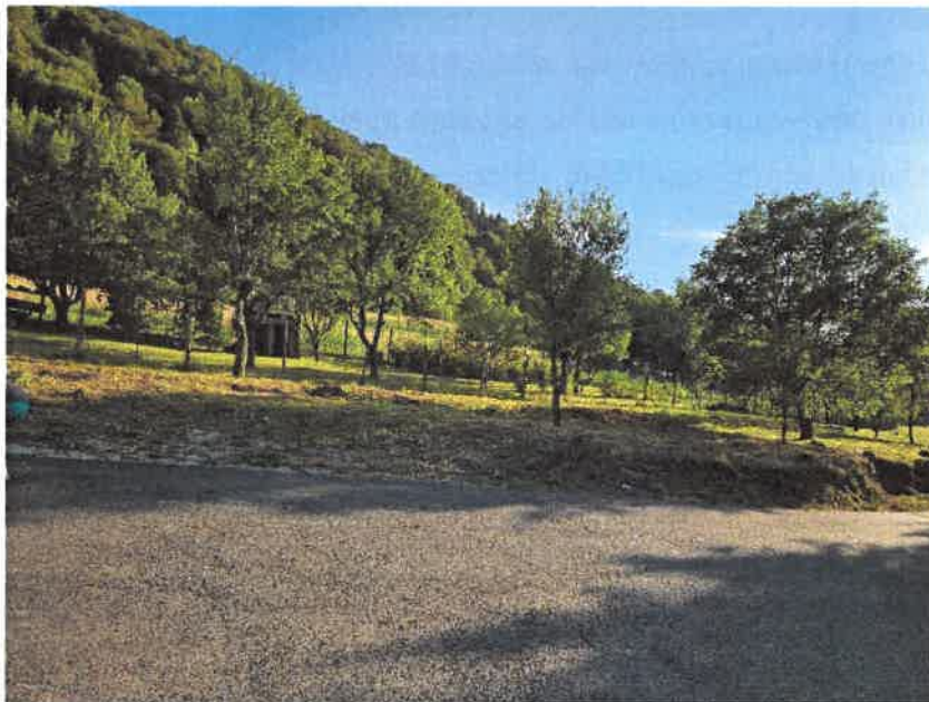
Slika. Rekonstrukcija postojećeg puta u ulici Veliko Selce
